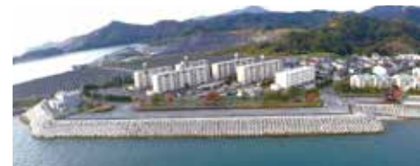
海岸(高潮)白野江護岸工事(30-3) ※台風時の高潮対策
