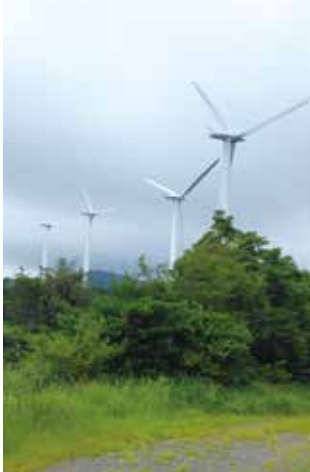
陸上風車点検現場
