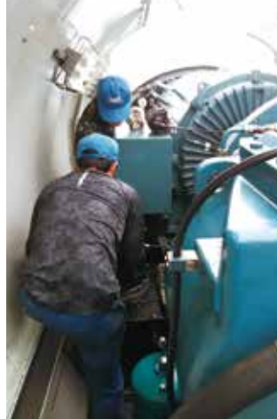
風車ナセル内の点検作業中
