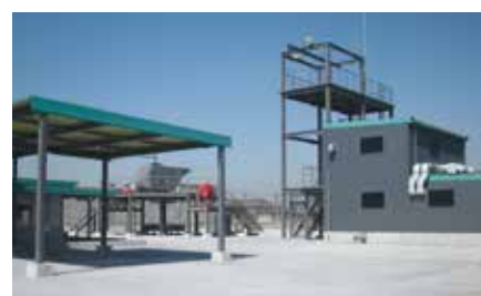
消火訓練・高所訓練
