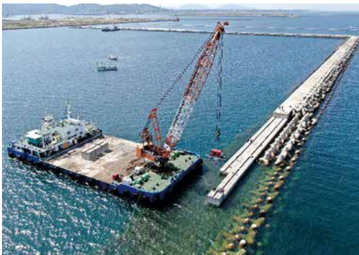
廃棄物響灘東(北)護岸工事(3-2) ※ジャイロマスター工法使用
