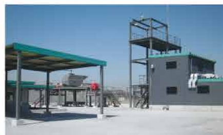
消火訓練施設
